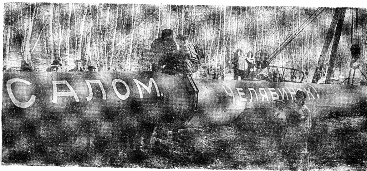
«Салом, Челябинск!» — Здравствуй, Челябинск! Идет сварка последних труб.
